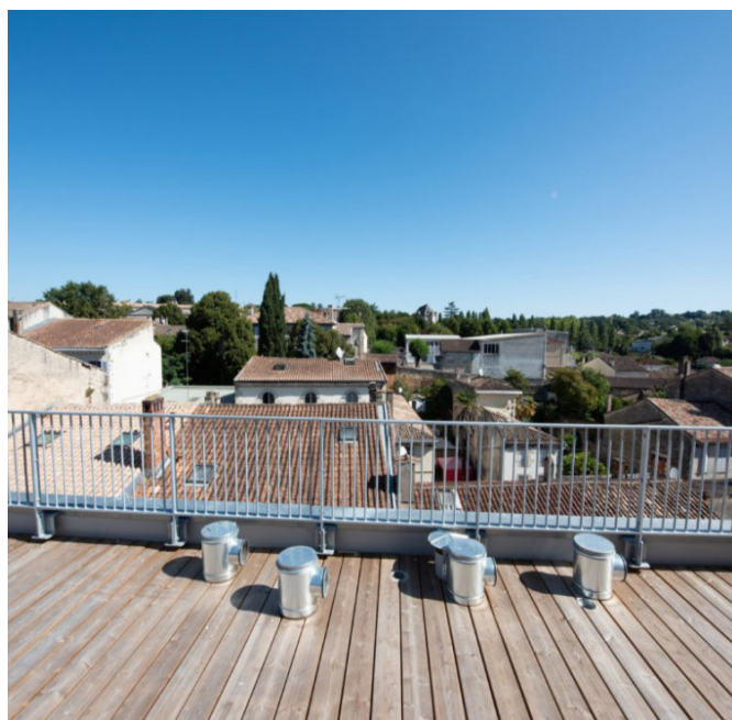
Figure 3 : Protections solaires - Rénovation Le Jardin sur le Toit – La Réole
