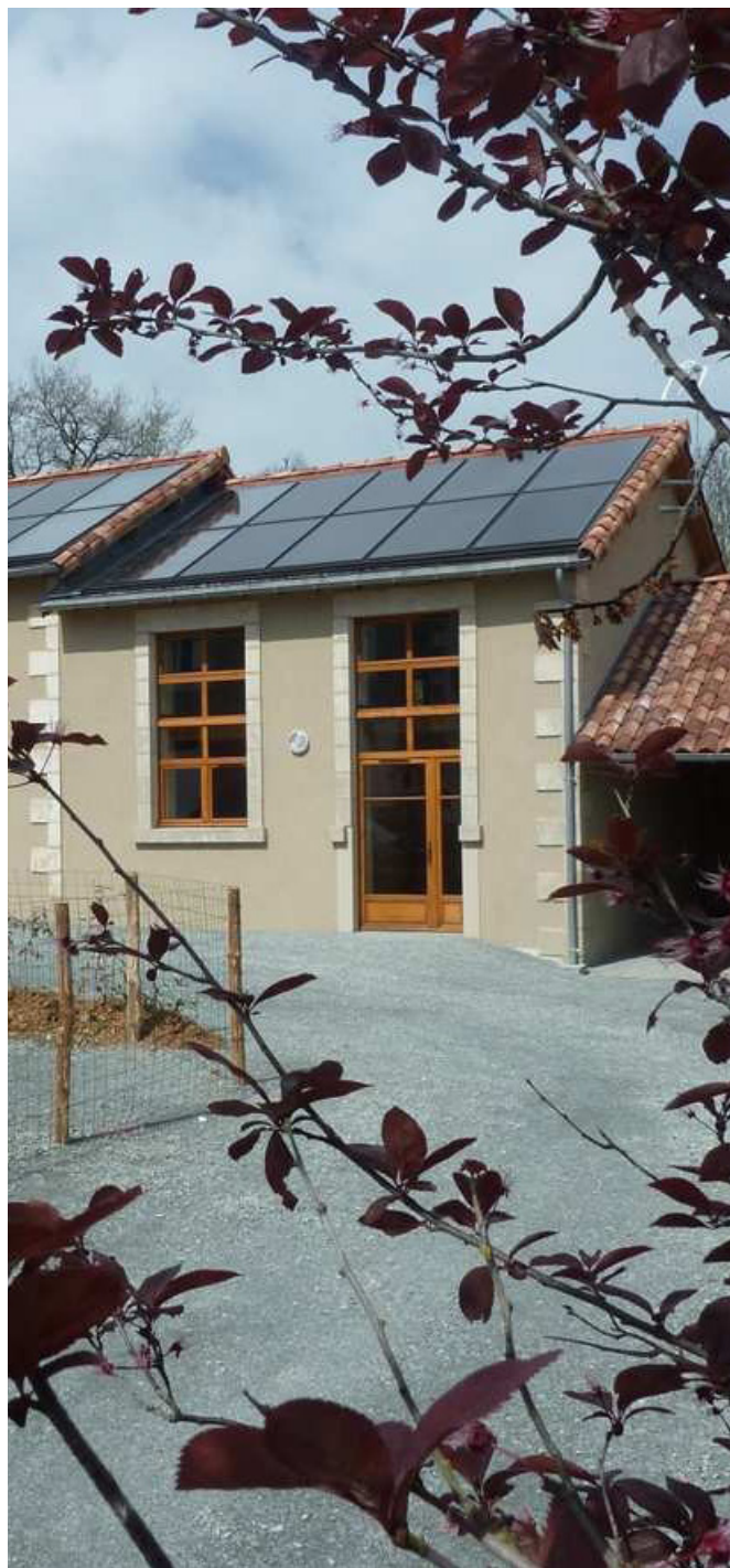
Figure 2 : Rénovation d'une ancienne école en deux logements – MO : Commune les Forges – Lauréat appel à projet régional – Architecte : Atelier Métisse
