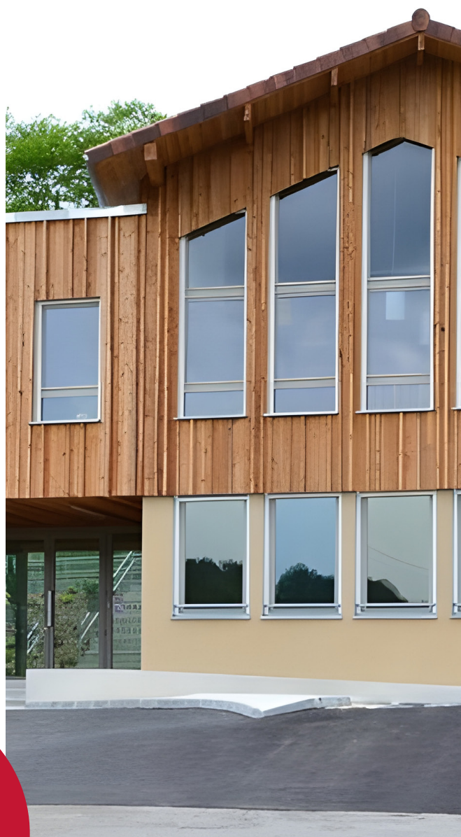
Figure 17 : Tertiaire - BBC Effinergie Rénovation - MO Mairie de St Paul - ARCHITECTE : Ox Architectures
