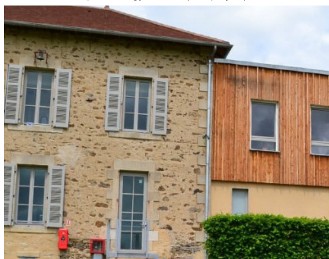
Figure 13 : Tertiaire - BBC Effinergie Rénovation - MO Mairie de St Paul - ARCHITECTE : Ox Architectures
