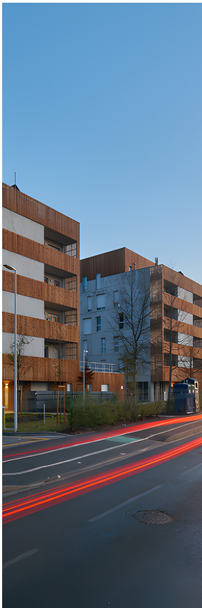
Figure 50 : Logements collectifs - Public - BBC Effnergie Rénovation - Architecte : Lanoire & Courrian - Mo : Icf Habitat Atlantique
