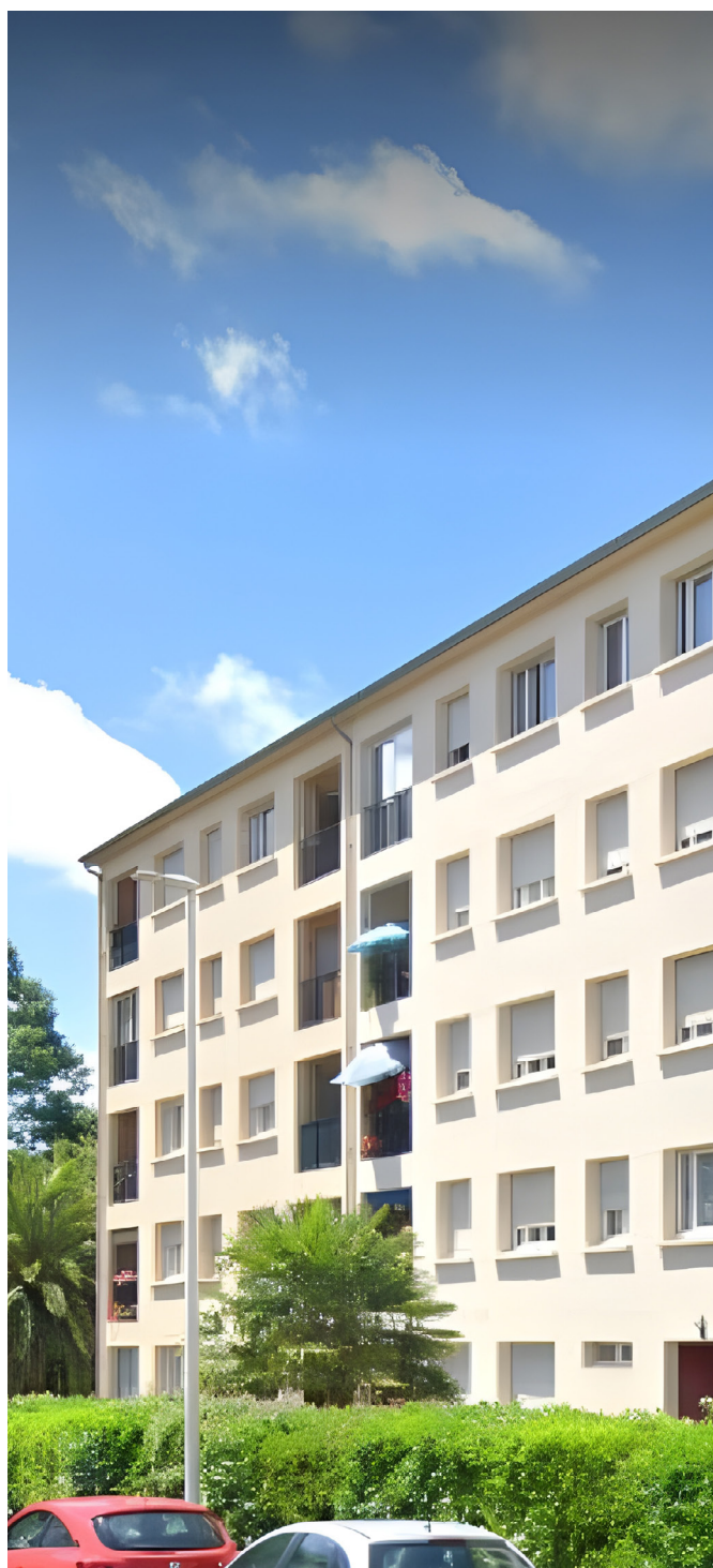
Figure 43 : Logements collectifs - BBC-Effinergie Rénovation - MO : SILAB (filiale groupe CILSO) et PACT HD du Pays Basque
